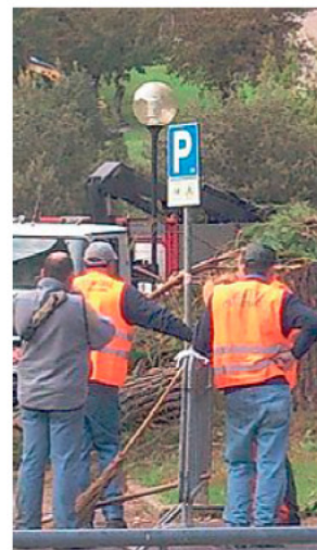
Gli operai al lavoro in viale Galilei a Figline per tagliare altri dodici alberi
